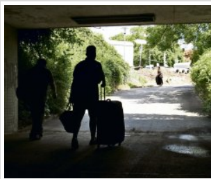
Auf geht's: Die 30 Jahre alten Tunnelrampen am Bahnhof Rethen, wie diese an der Ostseite, weisen mit 8,5 Prozent eine deutlich höhere Steigung auf, als die im Sinne der Barrierearmut maximal empfohlenen 6 Prozent. Köhler
